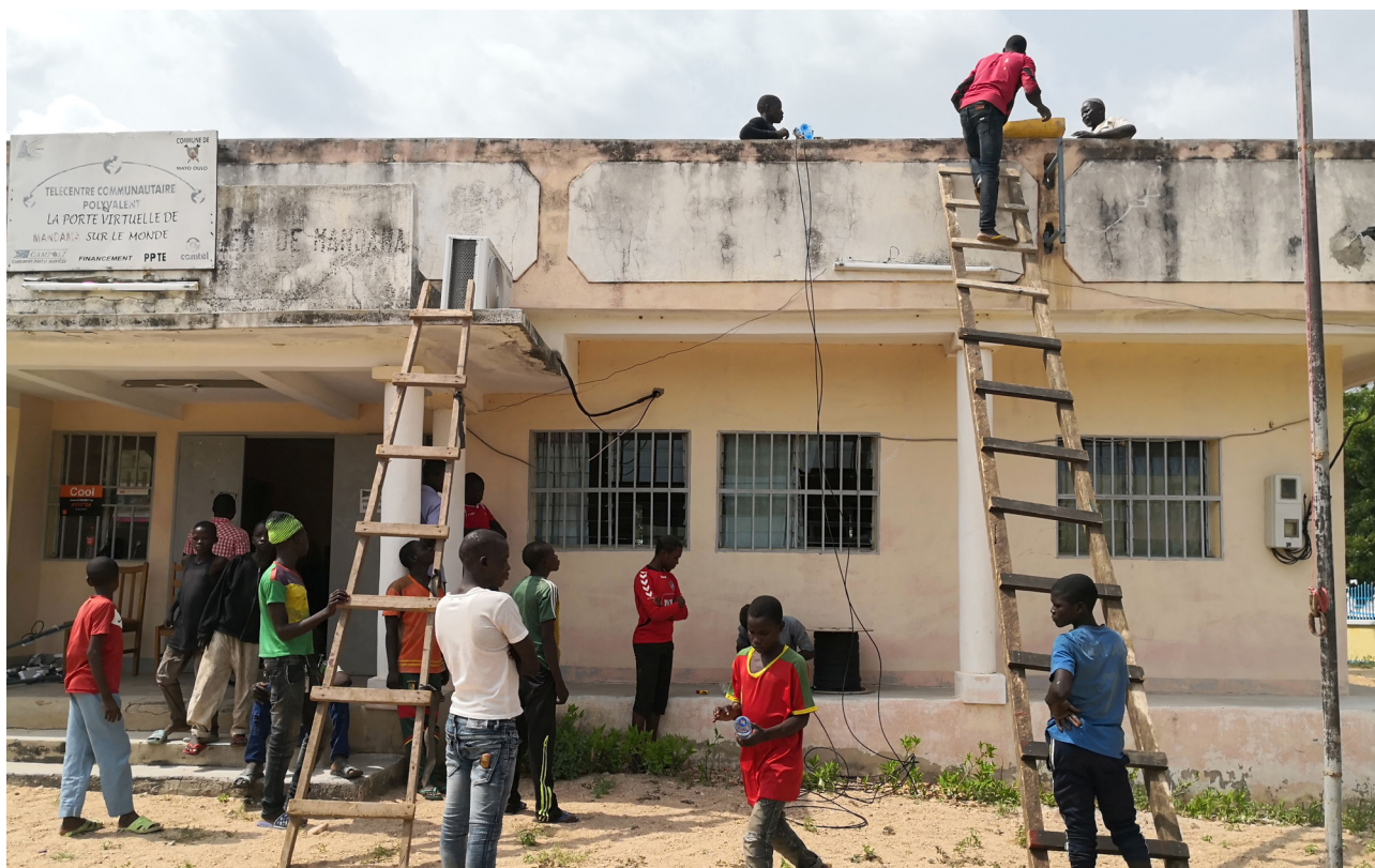
INSTALLATION D'UN RÉSEAU WI-FI À BIBEMI.
